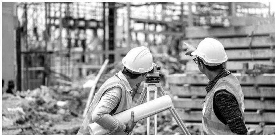
Với sự gia tăng số lượng các dự án và quy mô ngày càng lớn, việc kiểm soát chi phí thi công đang trở thành một thách thức lớn
