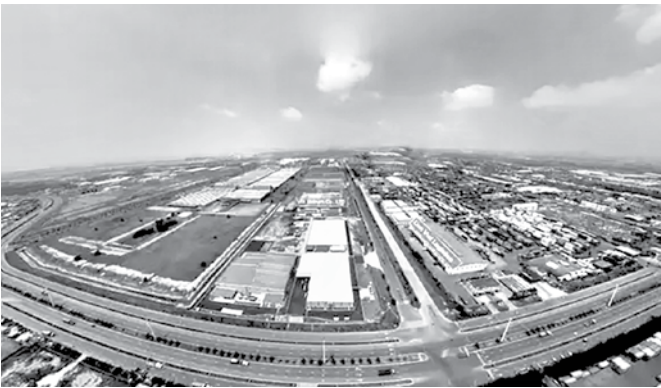
KCN MP Đình Vũ mang lại dự án 22 triệu USD do Công ty Kim Khí Bắc Việt làm chủ đầu tư
