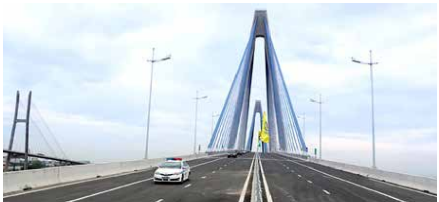
Đội ngũ kỹ sư Việt Nam đến nay đã hoàn toàn làm chủ công nghệ từ thiết kế đến thi công cầu, bao gồm cả các cầu có kết cấu phức tạp
