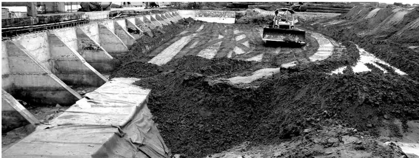
Hình 2. Thi công bãi san lấp sau cầu sau khi làm xong kè sau cầu
