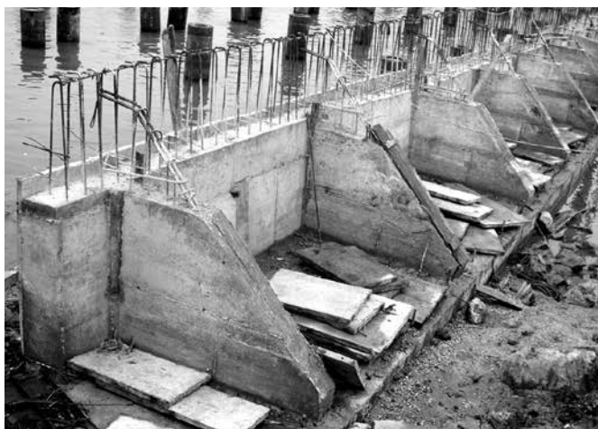
Hình 3. Thi công tường góc kè sau cầu
