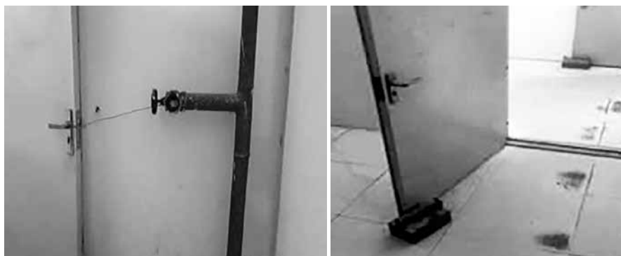
Hình 1. Người dân buộc dây, chặn gạch cửa thoát hiểm tại chung cư HH Linh Đàm
