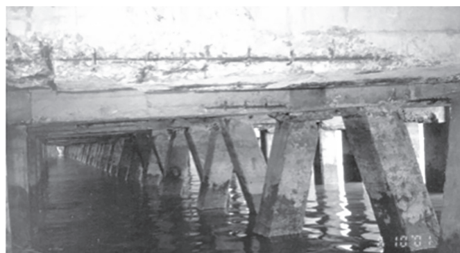
Hình 3: Cảng Cửa Cấm Hải Phòng sau 30 năm sử dụng
