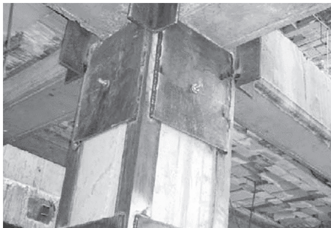
b) Gia cường cột bằng các kết cấu khung và tấm thép
