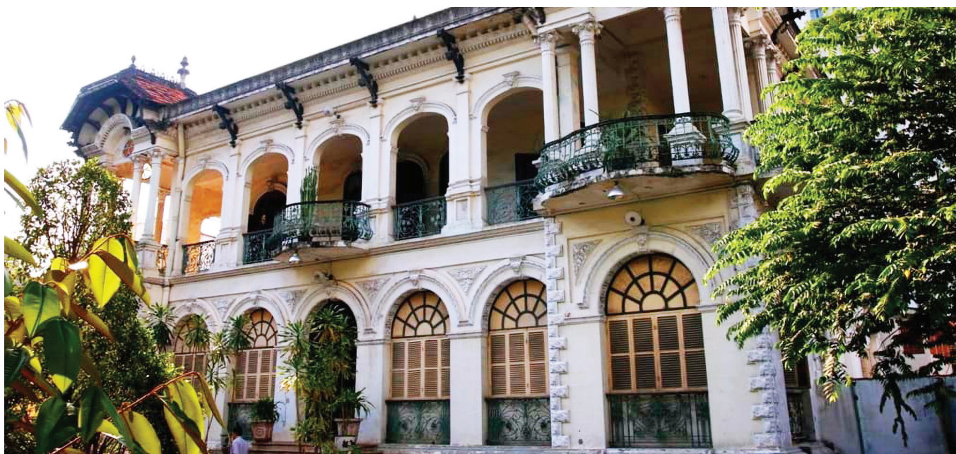
Việc bảo tồn, tôn tạo các công trình kiến trúc có giá trị còn nhiều bất cập
