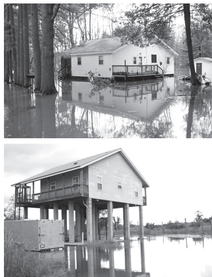
Hình 5. Nhà kiểu tầng rỗng nhằm chống ngập, chống ẩm tại đồng bằng Sông Mississippi, Hoa Kỳ
