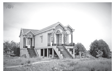
Hình 6. Nhà xây kiểu tầng rỗng (cao cẳng) trên nền đất trũng thấp ở Cà Mau
