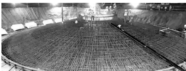
Hình 3. Mặt bằng bố trí thiết bị đổ bê tông móng
