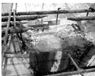
Hiện trạng thép dầm sàn bị ăn mòn(sau phá dỡ)
